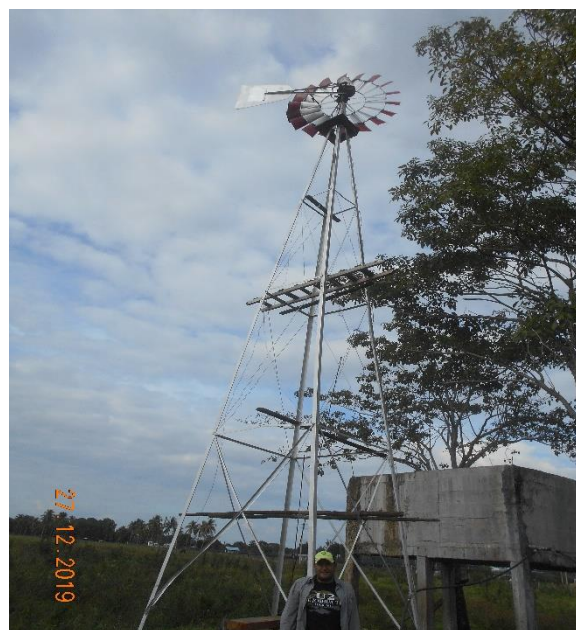
Verificación física de la construcción de un pozo profundo
