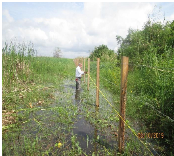
Verificación de la construcción de cerca de alambre
